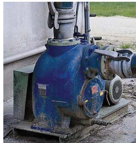
Насос T Series™ перекачивающий отработанную воду в сборный резервуар на крахмальном заводе в Дании.
