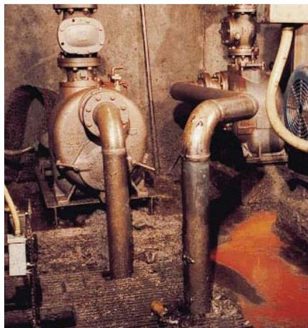
Насос T Series™ обрабатывает твердые примеси и абразивные жидкости на сталеплавильном заводе, штат Огайо, США.
