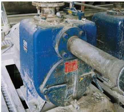
Насос U Series® перекачивает абразивную отработанную воду на бетонном заводе в Нидерландах.
