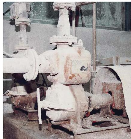
Насосы 10 Series® перекачивающие сточные воды с твердыми примесями на сталеплавильном заводе в штате Огайо, США.
