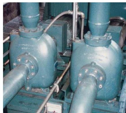
Насосы 80 Series® качают жидкость охлаждения на автомобильном заводе в штате Мичиган, США.
