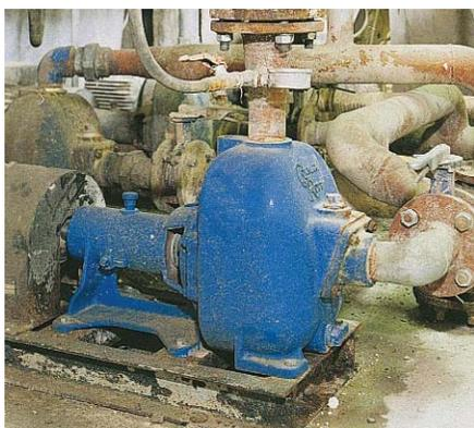
Насос 80 Series® перекачивает химические стоки в резервуар-отстойник в Нидерландах.
