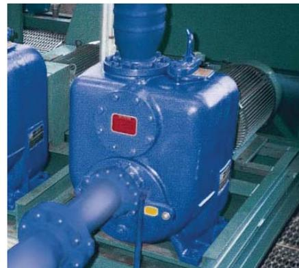
Насос U Series® перекачивает охлаждающую жидкость на фабрике пластмассовых изделий в штате Индиана, США.
