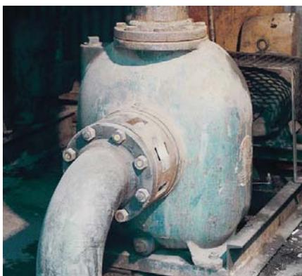
Насос 80 Series® качает зашламованную воду на сталеплавильном заводе в штате Огайо, США.
